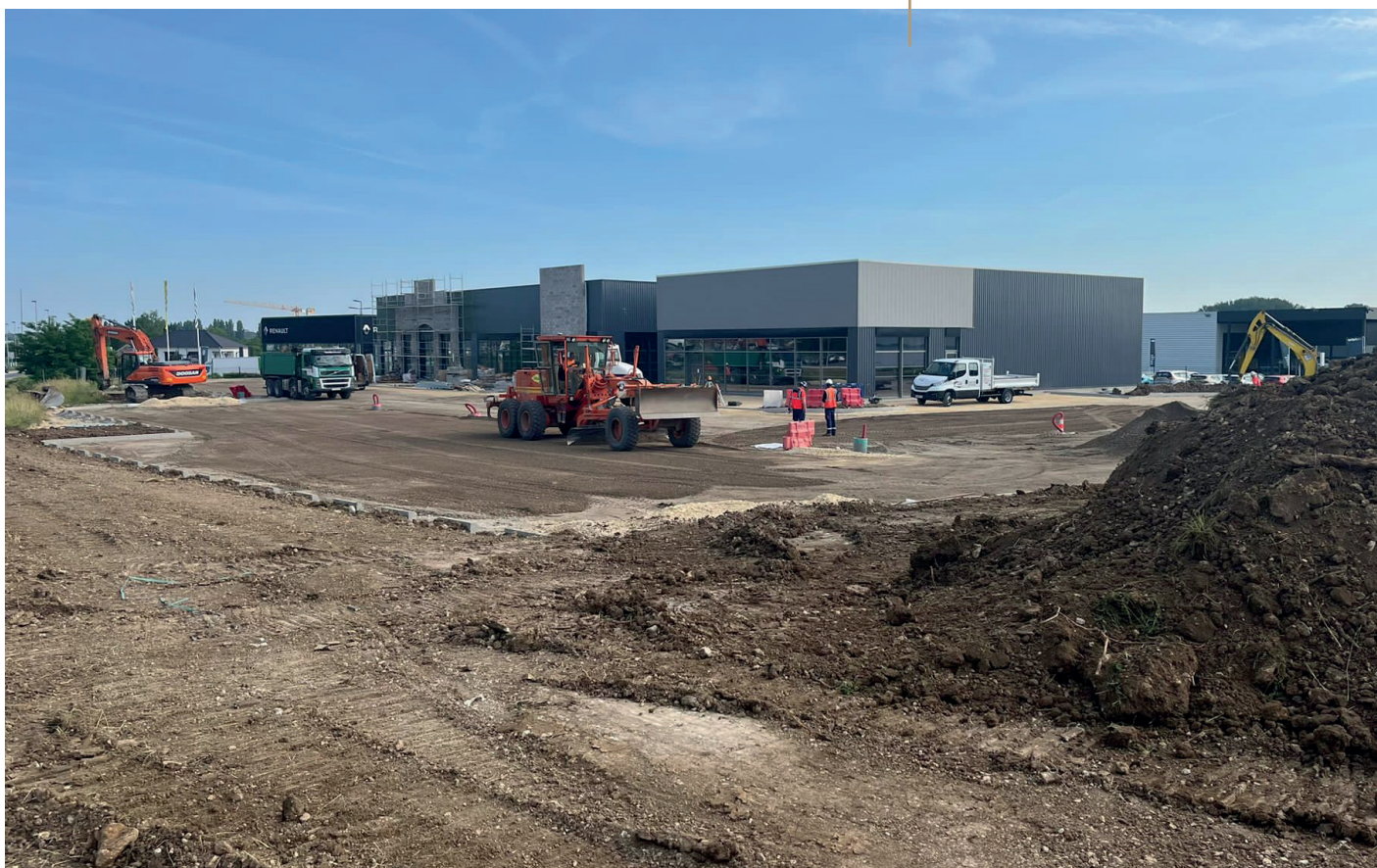
Chantier de la zone commerciale en juin 2023
